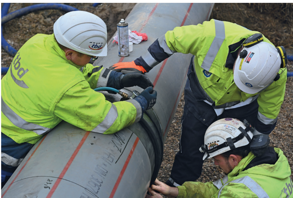
Abb. 2: Überprüfung der letzten Schweißnaht an der Zukunftsleitung im Dezember 2023
