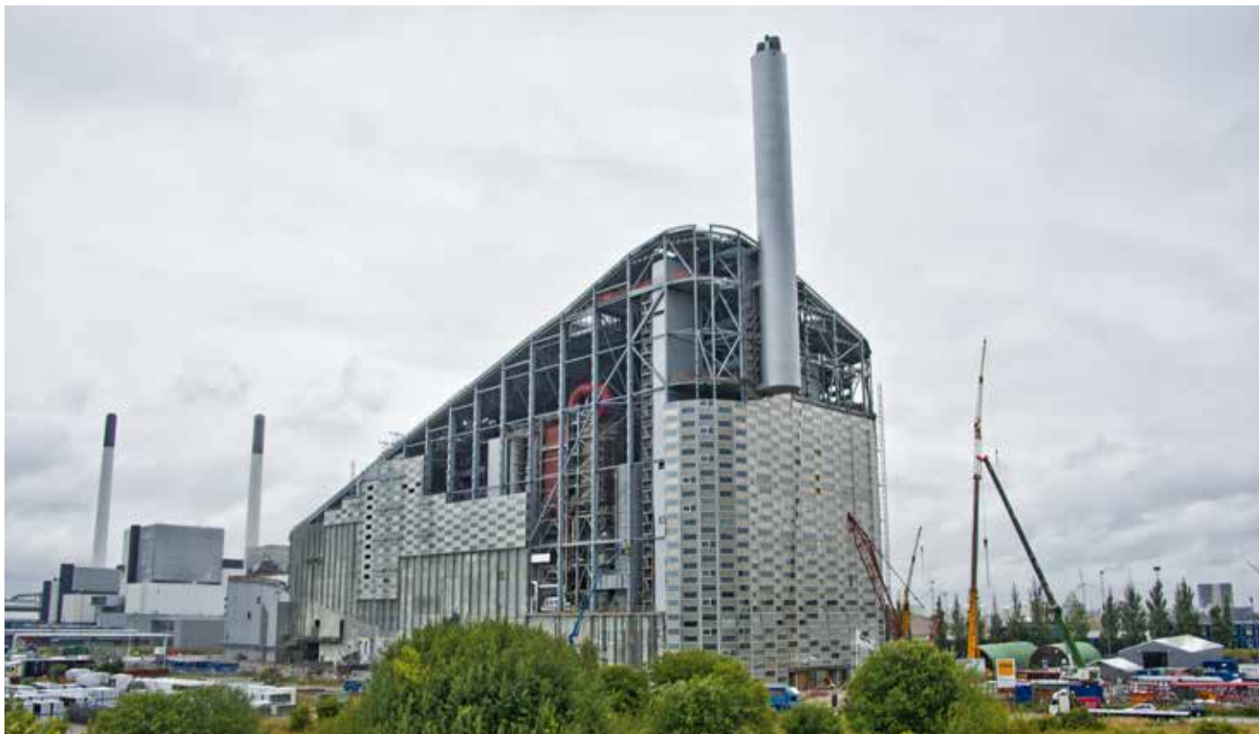
Die innovative Müllverbrennungsanlage „Amager Bakke“ in Kopenhagen wurde von der Züblin Stahlbau GmbH erbaut, u. a. mit MSH-Profilen
