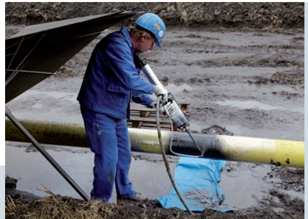
BILD 15: Nachumhüllung der Schweißnähte mit einer Polyurethanbeschichtung
