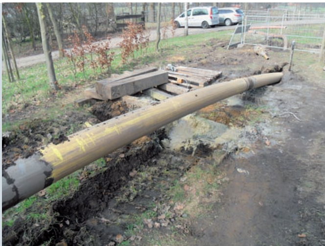
BILD 15: Nachumhüllung der Schweißnähte mit einer Polyurethanbeschichtung
