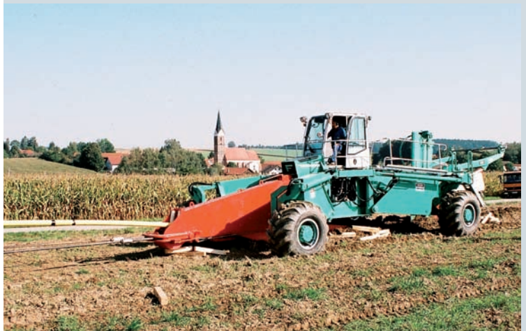
BILD 18: Pflügen einer Rohrleitung
