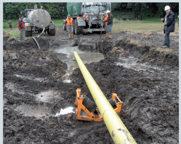
BILD 16: Pilotverlegung eines Polyamidumhüllten Rohres mit dem Spülbohrverfahren
