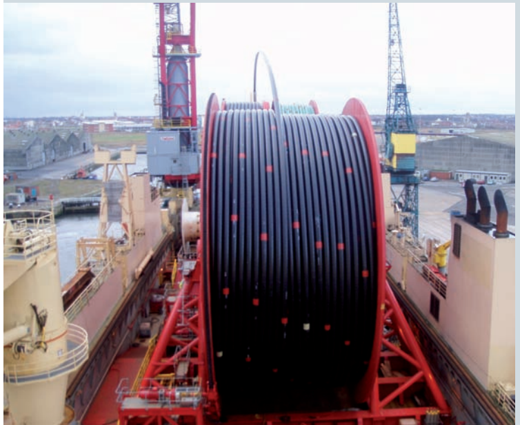
BILD 17: Offshore-Verlegung einer „gereelten“ Leitung
