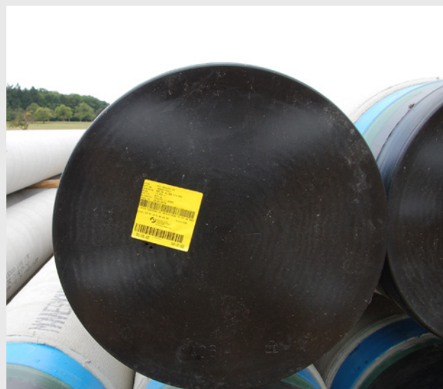
Bild 2: Rohre des für den Praxistest relevanten Bauabschnittes mit Barcode-Etiketten am Rohrende
