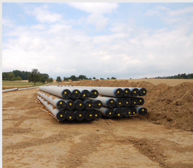
Bild 2: Rohre des für den Praxistest relevanten Bauabschnittes mit Barcode-Etiketten am Rohrende
