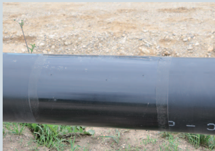
BILD 3: Verbindungsbereich mit Polyurethannachumhüllung
