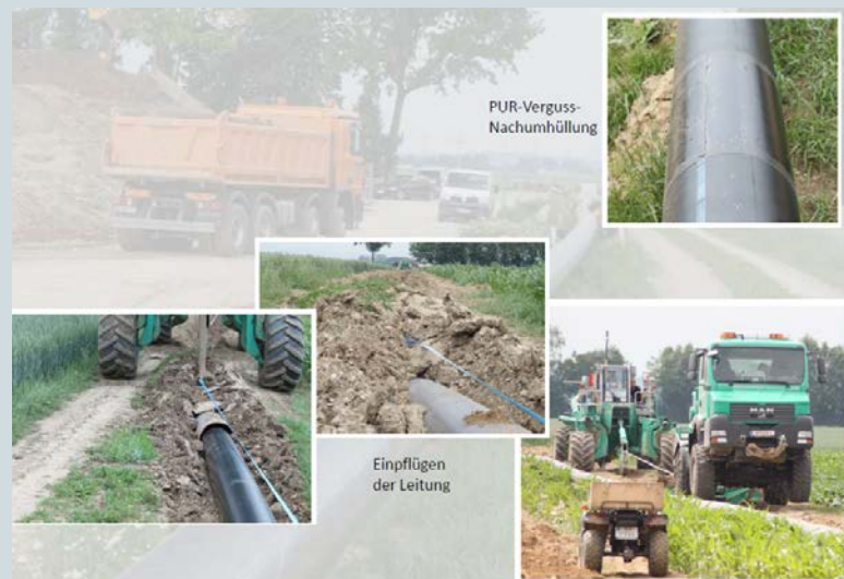
Bild 14: Die Umhüllungskombination von Polyethylen und Polyamid in der Pflugverlegung
