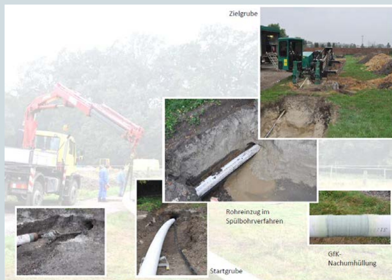
Bild 15: Die Umhüllungskombination von Polyethylen und Polypropylen im Spülbohrverfahren
