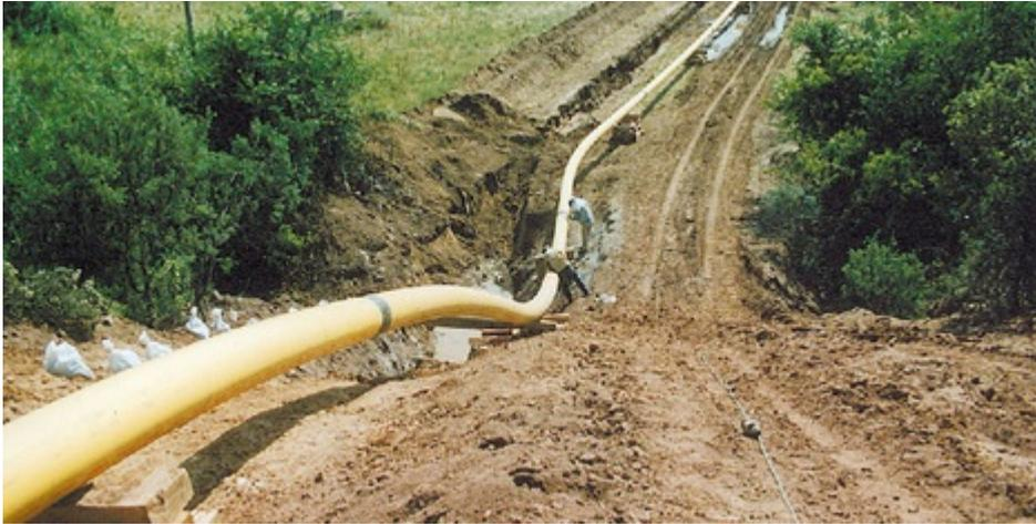
Diese Verlegeanleitung enthält Hinweise für die Verlegung und Nachumhüllung von Stahlrohren mit Schweißverbindungen. Darüber hinaus gelten die allgemein gültigen technischen Regeln für Wasserrohrleitungen z. B. die EN 805 bzw. das DVGW-Arbeitsblatt W 400, für Gasleitungen z. B. die EN 12007 und EN 1594 bzw. die DVGW-Regelwerke G 462 und G 463.
